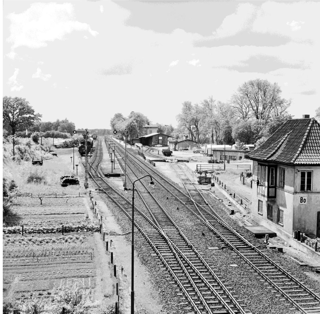
Blick von der Brücke Tremsbütteler Weg auf die Bahnhofsanlage im Jahr 1965. Im Vordergrund rechts das Stellwerk „Bo“, dahinter die Drehscheibe für die Loks, der Güterschuppen, der Bahnhof. Vorne links Gemüseärten., hinten Güterzug.
